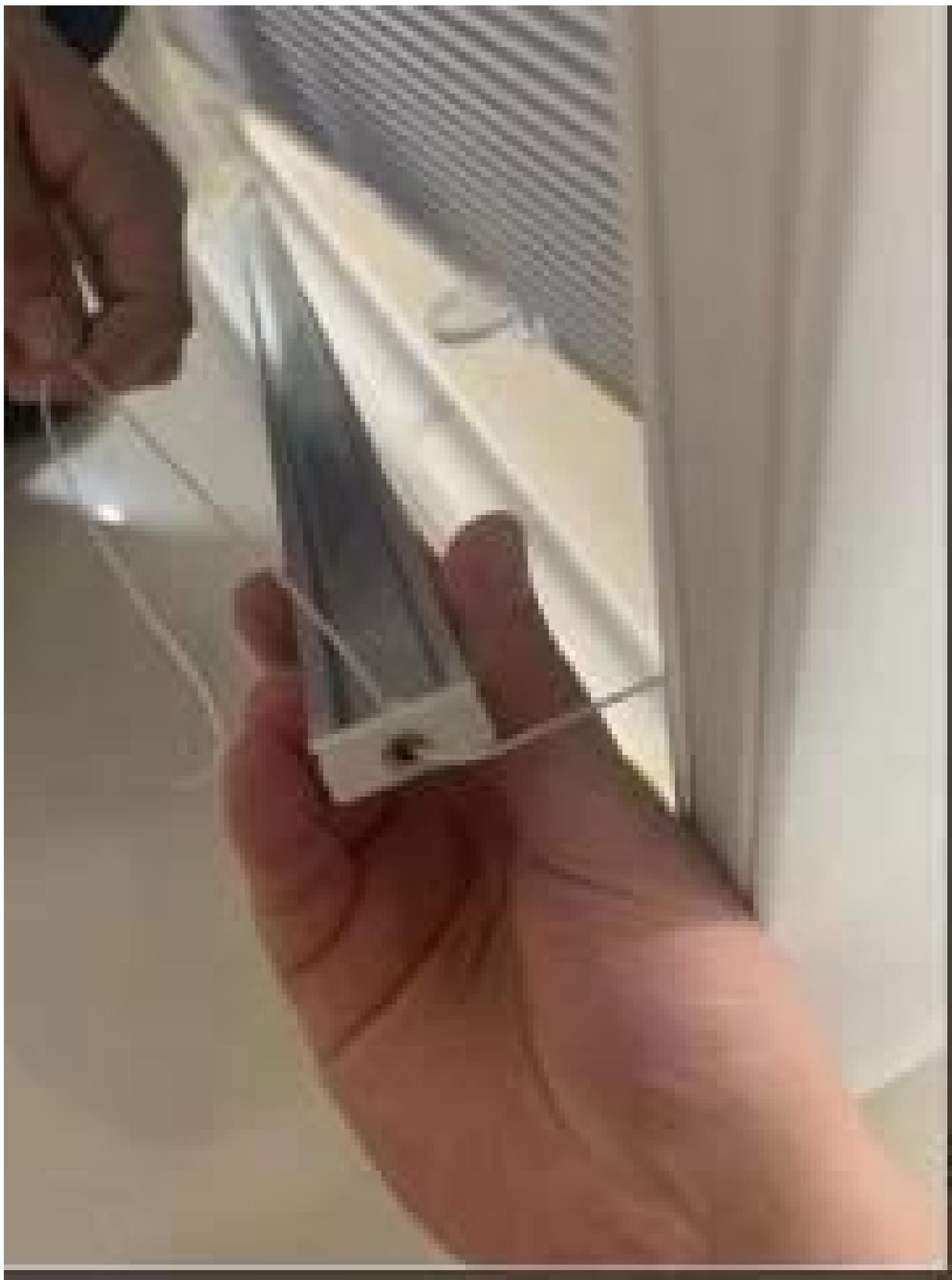
9. Жалюзи можно снять, нажав на **назад** кронштейна, и шторка освободится.
